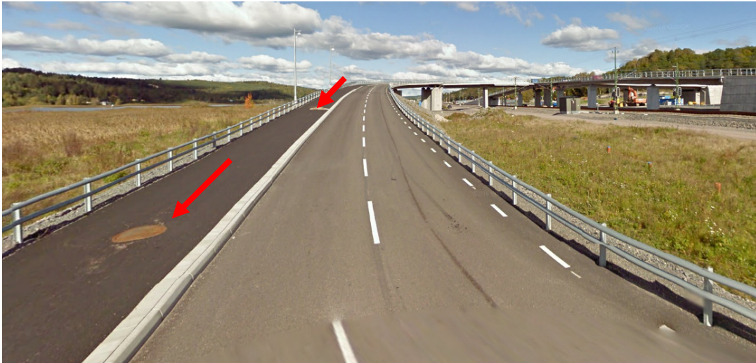
Figur 9. Markfoto visande påfartsrampen i Tpl Nödinge samt dextrarna som skyddar de två bäglslangarna.
