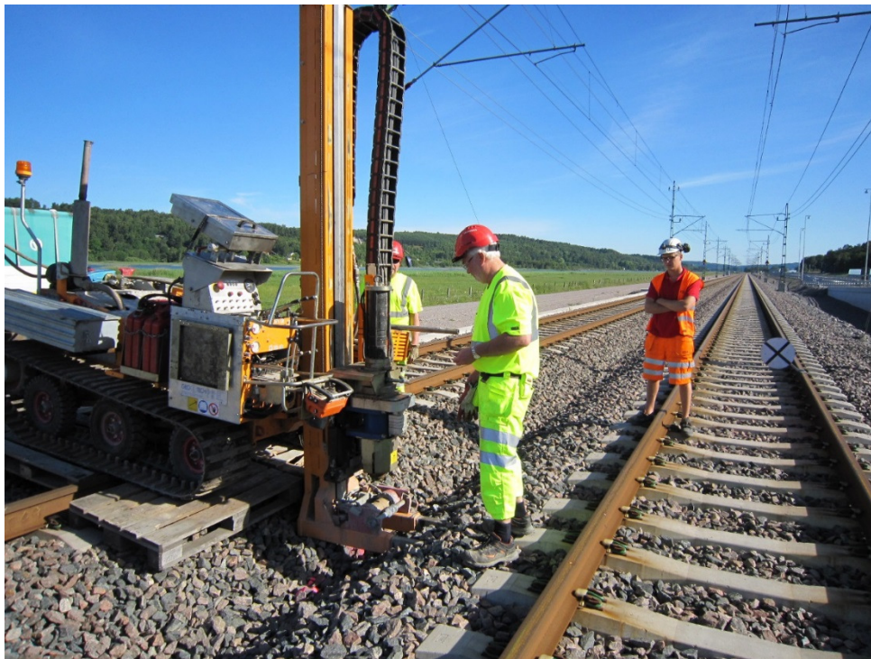
Figur 14. Foto visande topografin i läget för mätsektionen i Stora Viken samt borrhingsarbetet i samband med installationen av den södra bälgslangen i Trollevik.
